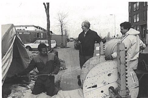
De aan de oude kern bevestigde glasvezelkabel kan worden ingevoerd.
