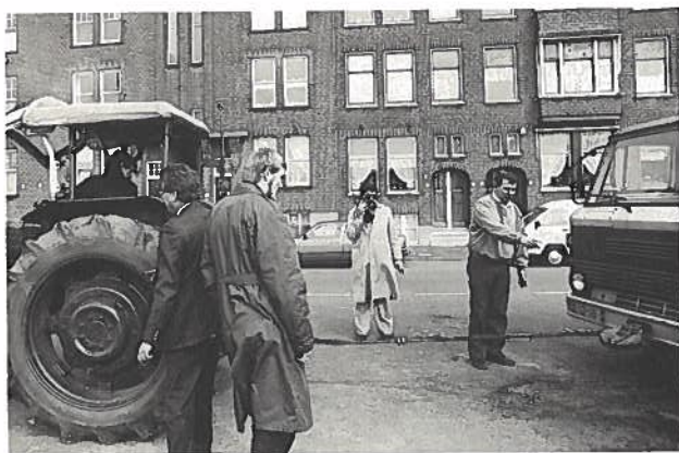
De koperen kern kan aan de tractor worden vastgebonden.
